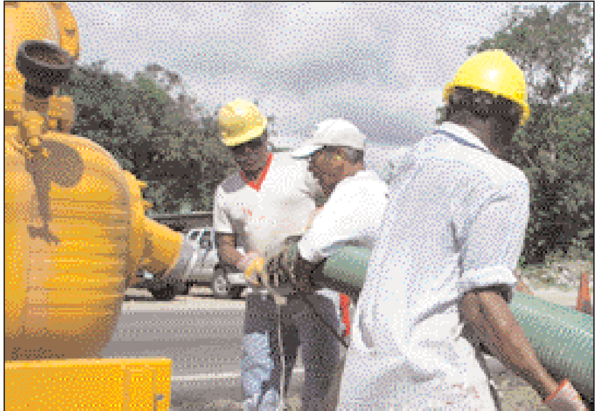
Trabajadores canaleros en Chilibre.
