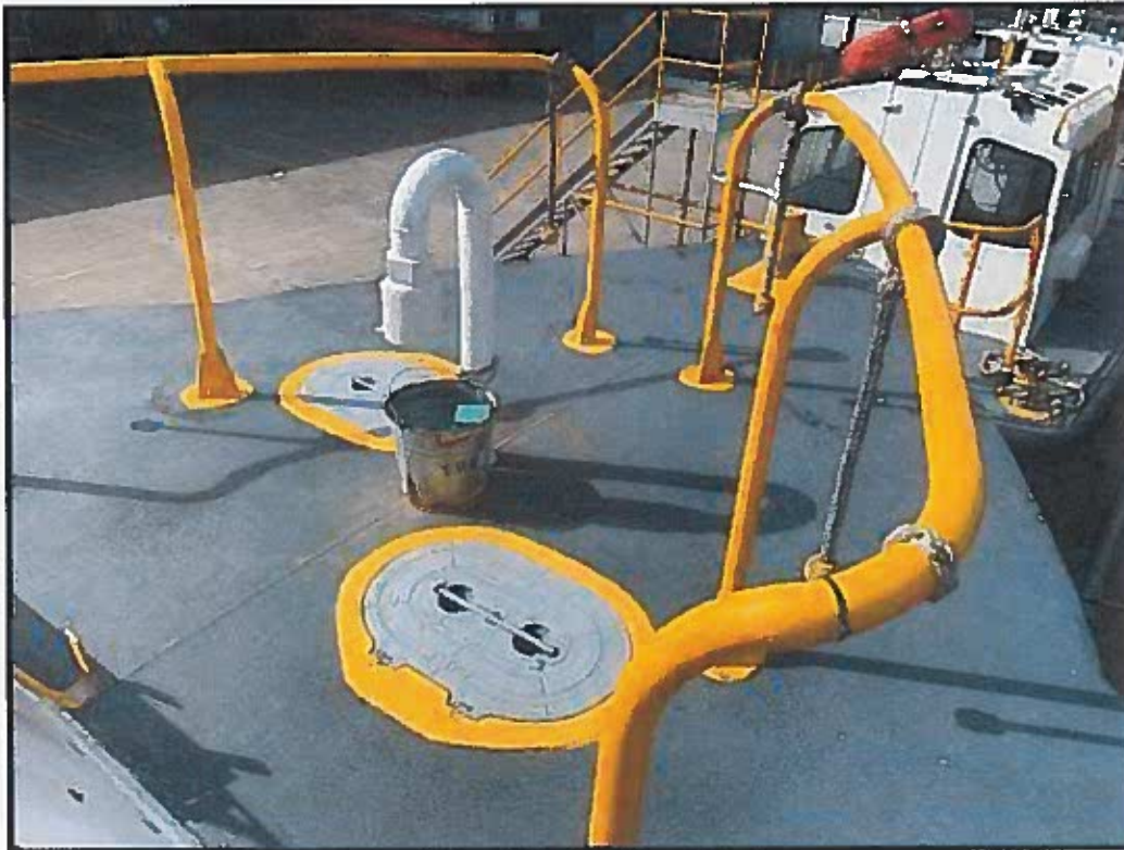
Foto No.2 Cubierta en área de proa
