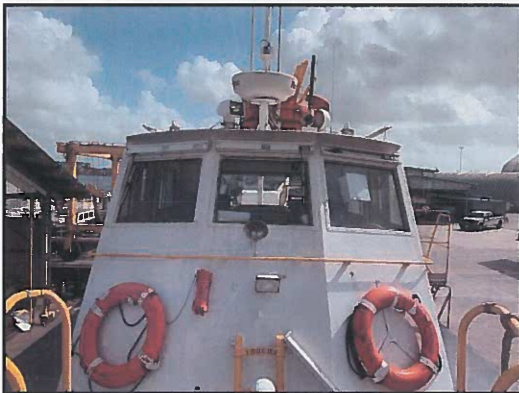
Foto No.5 Frente de Cabina de control
